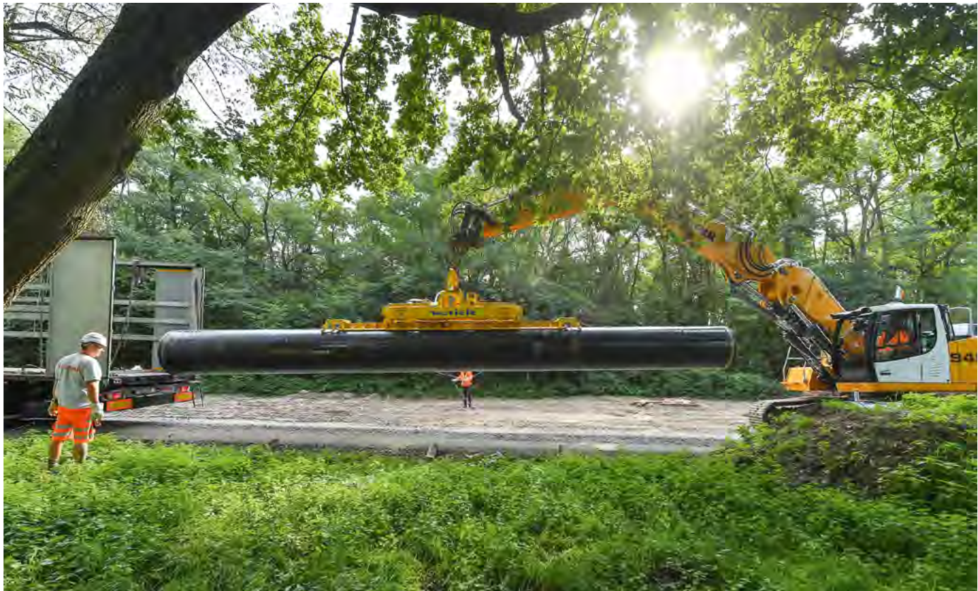
Der Bau der Neuen Riedleitung ist das größte Infrastrukturprojekt von Hessenwasser – die redundante Leitung ist essentiell für die Wasserversorgung der Metropolregion.
