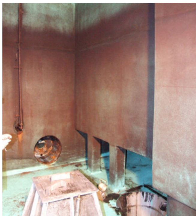
Bild 6: Entleerter RefiFloc-Filter
