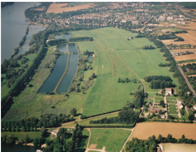
Bild 1: Wasserwerk Schierstein im Südwesten der Stadt Wiesbaden
