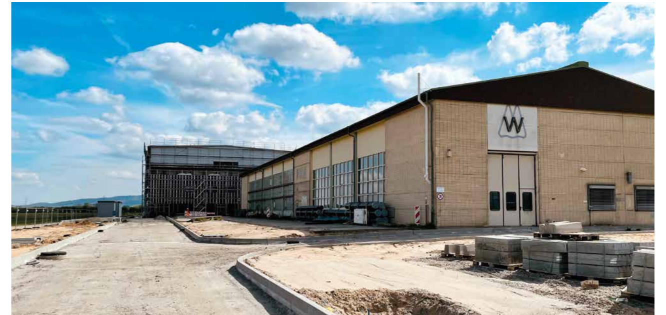
Neubau des Wasserwerks Allmendfeld
