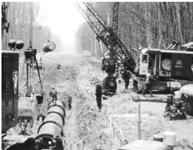
Rohrverlegung im Rüsselsheimer Wald 1963, aus: Der Beitrag der Riedwerke zur Wasserversorgung Rhein-Main, MdL Martin Schlappner (Hrsg.)
