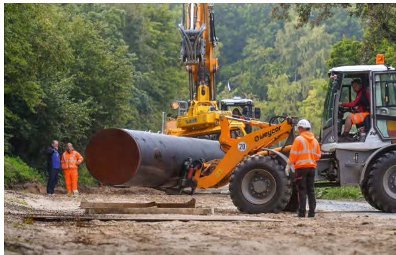
Bau der Neuen Riedleitung, 1. Bauabschnitt Nord, Rüsselsheimer Wald, Rohrdurchmesser DN 1000
