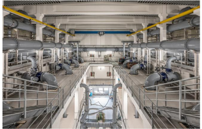
**Bild 4:** Blick ins Innere der Aufbereitungsanlage: Ebene der Riesler (oben links und rechts hinter den großen Rohrleitungen zu sehen) und Filterzuläufe
