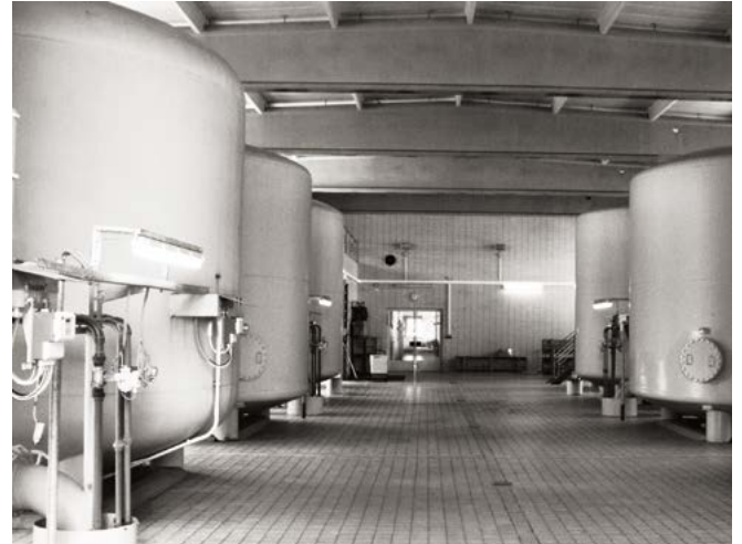
Ein Blick in die Filterhalle
