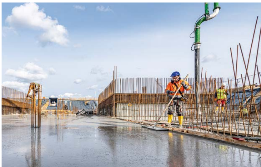
Glättarbeiten am frisch eingebauten Beton
