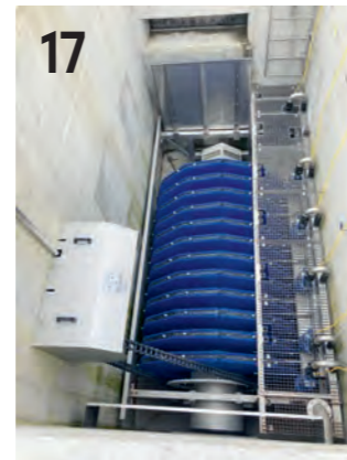
Kläranlage Mörfelden-Walldorf erhält eine vierte Reinigungsstufe.
