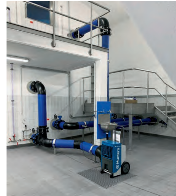
Technische Ausrüstung – Rohrleitungsinstallation
