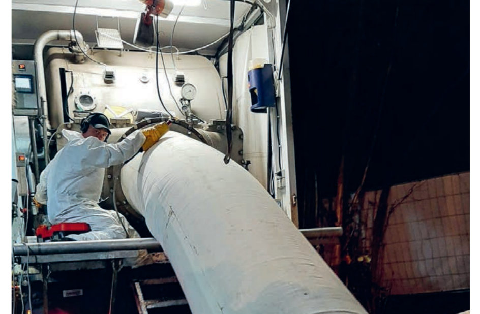
Bild links: Was hier zu Beginn der Arbeiten gefaltet auf dem Boden liegt, wird im Laufe der Sanierung zu einem voll tragfähigen, trinkwasserkonformen Rohr. Bild oben: Um den (noch) flexiblen Schlauchliner in das Altrohr einzubringen, wird er mit Druckluft eingepulst. Anschließend wird der mit Epoxidharz getränkte Schlauchliner mittels heißem Wasserdampf ausgehärtet.
