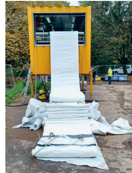
Bild links: Was hier zu Beginn der Arbeiten gefaltet auf dem Boden liegt, wird im Laufe der Sanierung zu einem voll tragfähigen, trinkwasserkonformen Rohr. Bild oben: Um den (noch) flexiblen Schlauchliner in das Altrohr einzubringen, wird er mit Druckluft eingepulst. Anschließend wird der mit Epoxidharz getränkte Schlauchliner mittels heißem Wasserdampf ausgehärtet.
