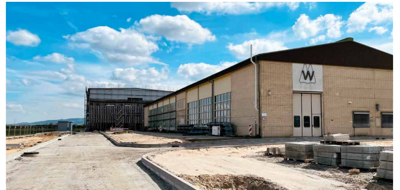
Neubau des Wasserwerks Allmendfeld
