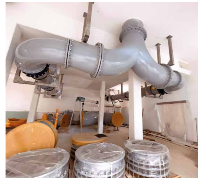
Blick in den Neubau des Wasserwerks Allmendfeld
