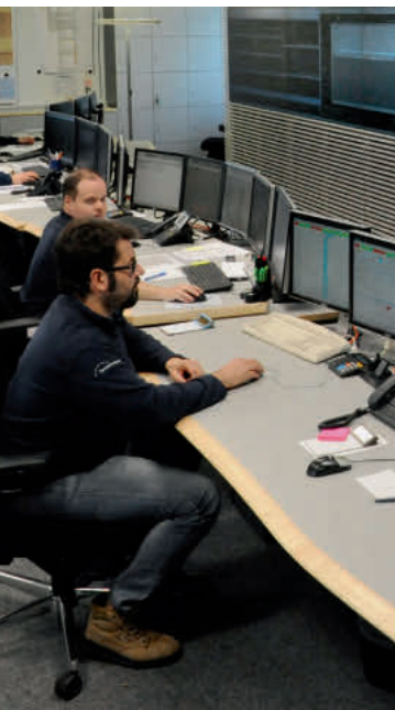
Im Wasserwerk sind Messgeräte installiert, die wichtige Leitparameter wie den pH-Wert, die elektrische Leitfähigkeit oder das Redoxpotenzial überwachen. Ihre Daten laufen permanent bei der Leitzentrale Hessenwasser (Bild) ein.
