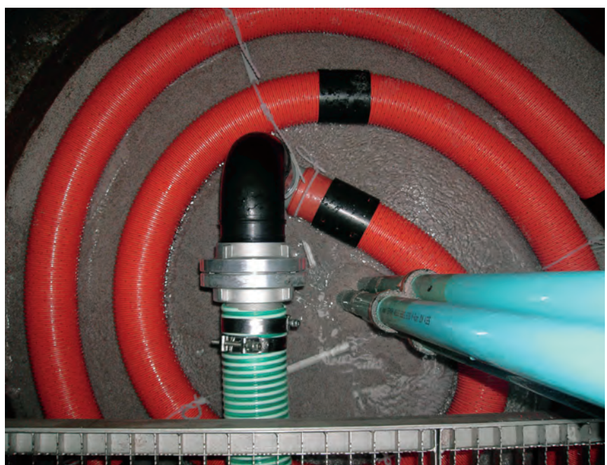
Abb. 3 Ausbau eines Kiesbohrlochs mit Einlaufschnecke
