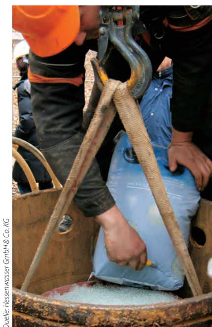
Abb. 2 Ausbau eines Schluckbrunnens mit Glaskugeln als Stützgerüst
